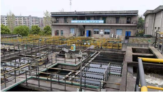
工农闸车站是华菱湘钢炼钢、轧钢区排水的中水处理水站。减少工农闸水站的来水，可以有效降低工农闸水站的水处理负荷，提高水处理水质，有效降低运行成本。报告期内，华菱湘钢提高各分厂水循环系统的浓缩倍数，增加中水用户，及时处理管网爆管漏水，降低损耗，优化中水管网运行。全年工农闸来水量降低 9,560,000m<sup>3</sup>。
