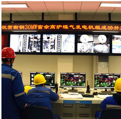
▲ 华菱衡钢高炉煤气发电机组
