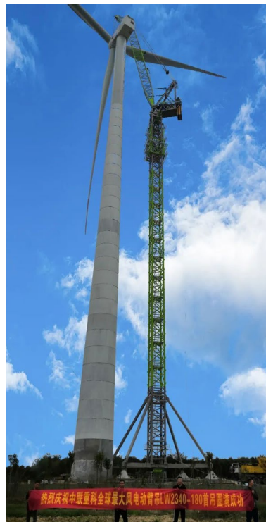
▲ 中联重科 LW2340-180 塔机——全球最大风电动臂塔机，采用公司臂架管
