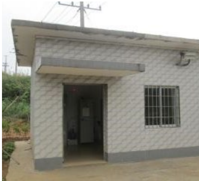
生活污水处理系统
