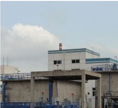
在线监测采样平台生产污水处理
