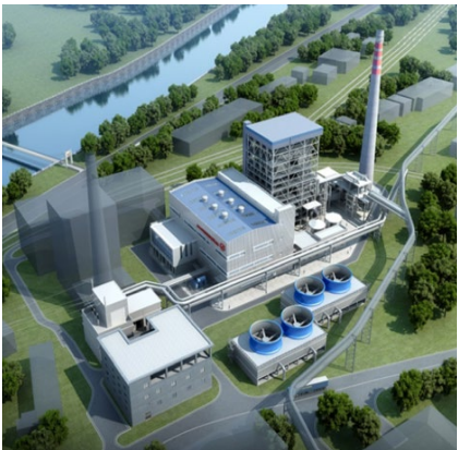
▲ 华菱涟钢新建 150MW 超高温亚临界发电机组
