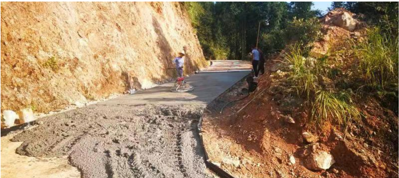
▲ 发动党员群众捐资 30 余万元修筑“平安路”，消除了学生上学穿行省道的安全隐患
