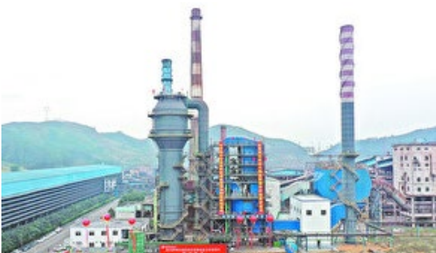
烧结超低排放改造项目
