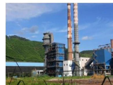
▲ 烧结机烟气脱硫脱硝
