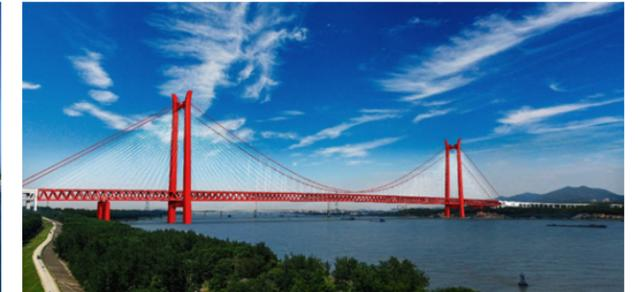
▲ G3 铜陵长江大桥 - 世界首座千米级分层斜拉悬索协作体系桥，采用公司独家供应的桥梁板和复合板
